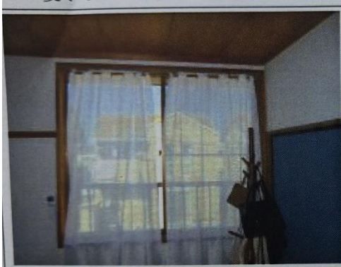
居室内の窓枠。カーテンレールがなく、伸縮式の棒でカーテンをかけている。
