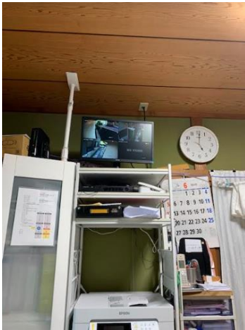
【室内の設置箇所】
