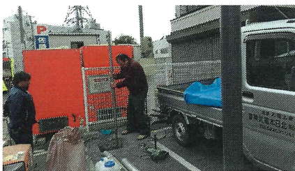
■ 充電設備の設置工事の様子
